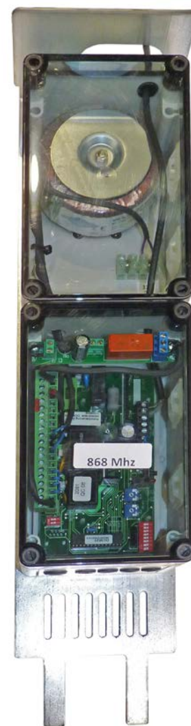
Montageplaat met transfo en sturingskast wordt in de bovenkant van de geleidingspaal geplaatst.
